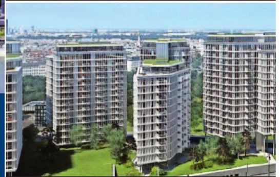
Die von Renzo Piano geplanten Parkapartments werden 2018 fertig.
